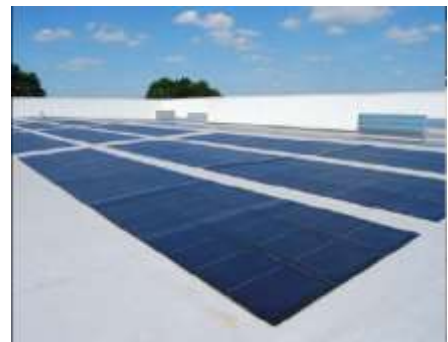
Figure 49 : exemple de membranes d'étanchéité installées sur un bâtiment industriel
