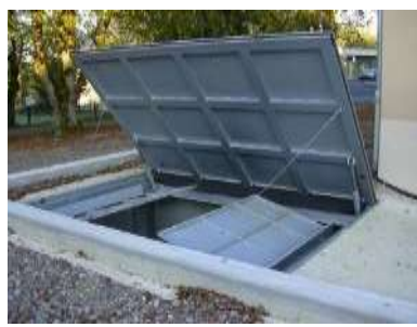
Trappe sur vérins hydrauliques (source Compte.R)
